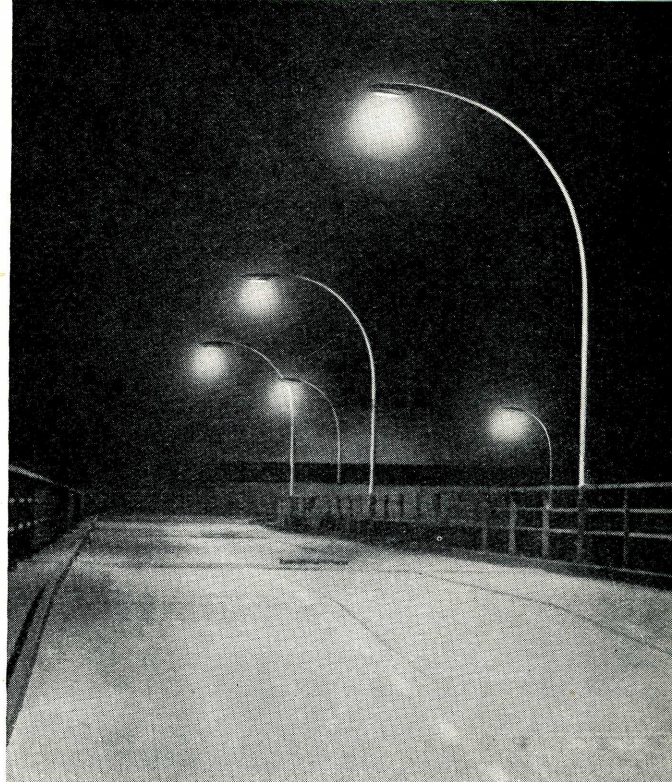
Gute Ausleuchtung einer Zufahrtstraße durch BGW-HQL-Lampen 250 W
